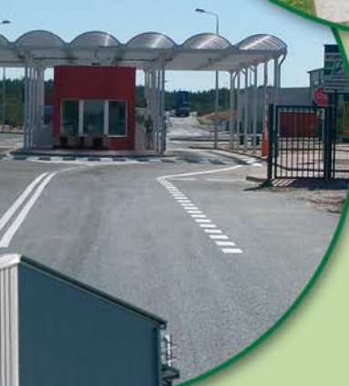
Mury oporowe na rondzie Hulanka w Bielsku-Białej. Retaining walls at Hulanka roundabout in Bielsko-Biała.
